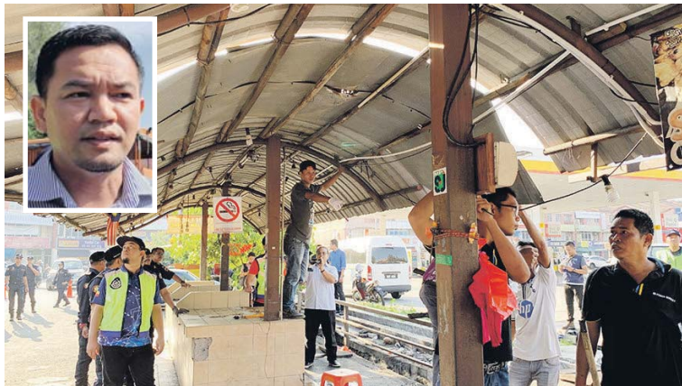
Selain struktur haram, sambungan bekalan air dan elektrik yang dibuat secara tidak sah. Gambar kecil: Mohd Zukurnain
