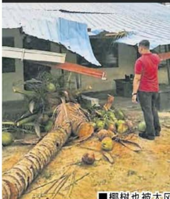
■椰树也被大风吹倒，压到部分屋顶。
