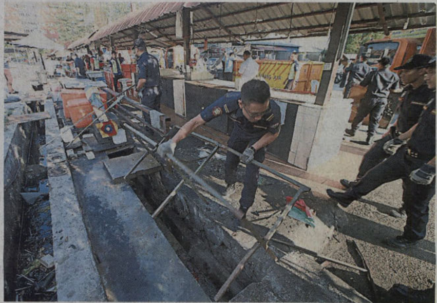
■ 滥用摊位作为食摊及非法扩建摊位的小贩，执法人员到场取缔时，即将违例扩建的屋顶、非法拉电等一一拆除及充公。
