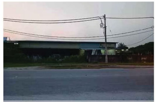
Sebahagian kedai di tanah TOL di PT 1766 di Kundang, berdekatan dengan Sungai Kuang yang didakwa dimiliki pihak ketiga.
