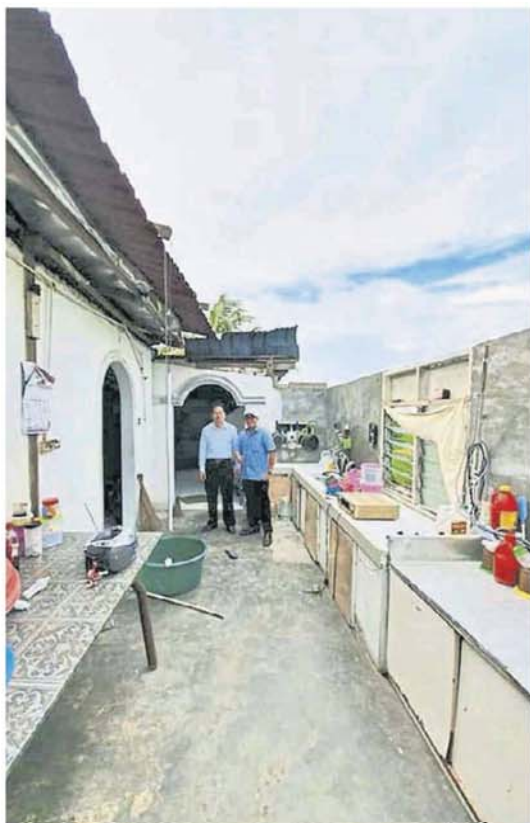
■在一间民宅，厨房上方的整个屋顶已被大风刮走。
