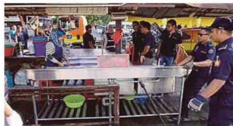
OPERASI merobohkan struktur tambahan tanpa kebenaran 36 kios di Taman Puchong Permai dan Taman Puchong Perdana, semalam.
